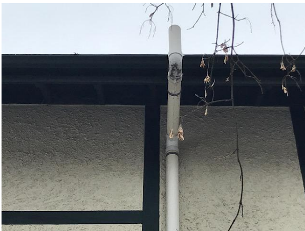
Radon discharge pipe
