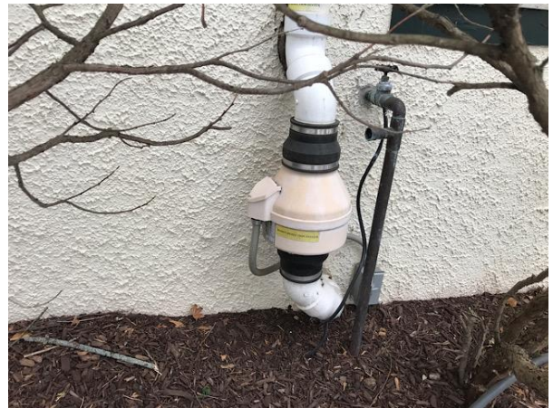
Radon vent fan
